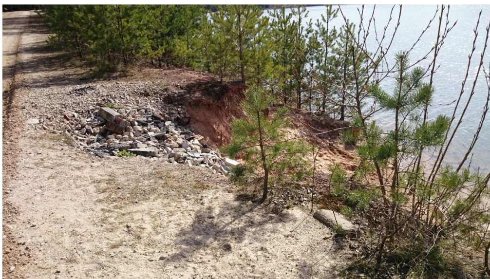
6. attēls Lielās Dubkalnu ūdenskrātuves izskalotā nogāze piebērta ar būvgružiem.
